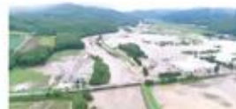
空知川の堤防決壊による浸水(国土交通省北海道開発局提供)
